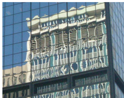
Figure 6. Déformation d'une structure périodique par les courbures locales. Le contrôle déflectométrique de la qualité de surface ONDULO est basé sur cet effet.
